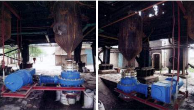
图4、现场使用中的高温球阀
