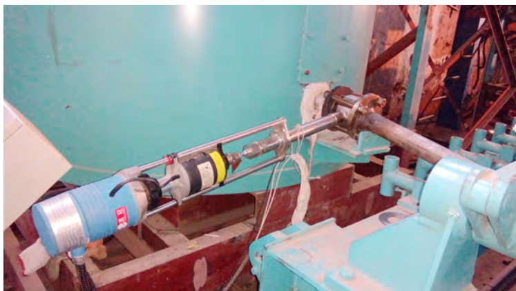
钢铁厂金属锡液流量控制
